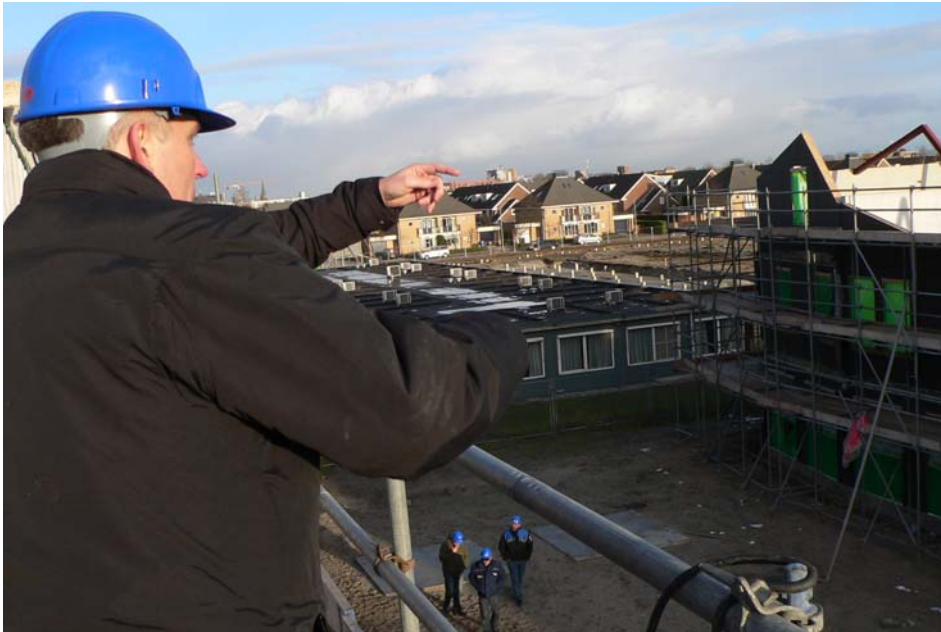
Cursisten Elementaire Bouwkunde A overzien de bouwplaats vanaf de steiger
